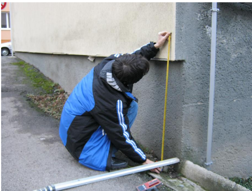
Obr. č. 3: Změření výškového rozdílu
